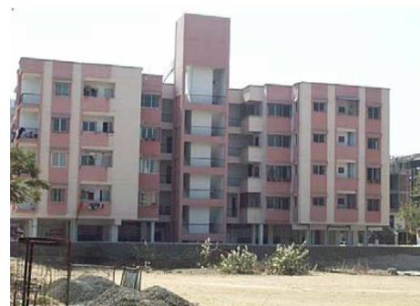
**Figura 12.2** Ejemplos de construcciones con entresijos blandos
