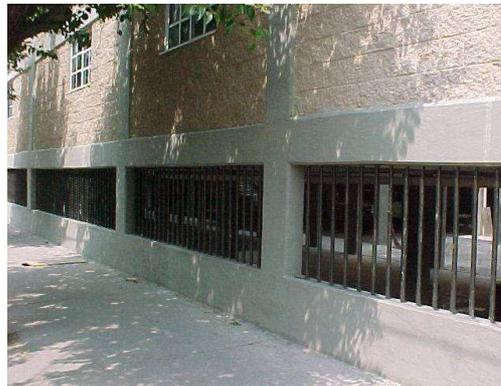
**Figura 12.16** Ejemplo de columnas cortas en semisótano
