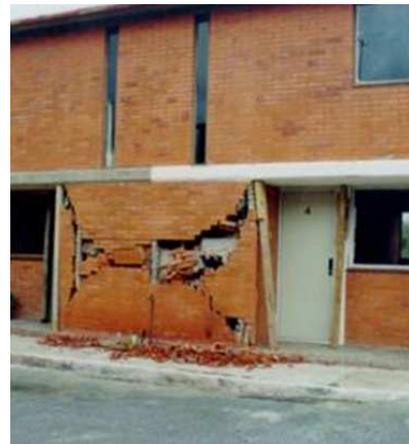
**Figura 12.8** Ejemplos de fallas de muros de mampostería en el primer entrepiso
