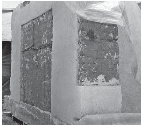
Figura 6: Muro reforzado con malla de vena pañetado.
